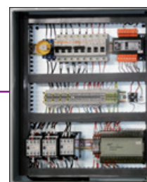
Pannello di comando di ampie dimensioni facile da raggiungere Tensione di comando 24 V CC Componentistica Siemens o Schneider
