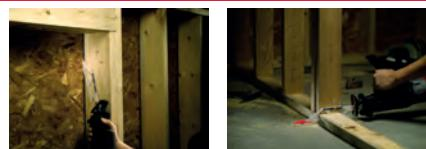
Lama per taglio e rimozione di serramenti e stand. Taglio a filo senza danneggiare il piano.
